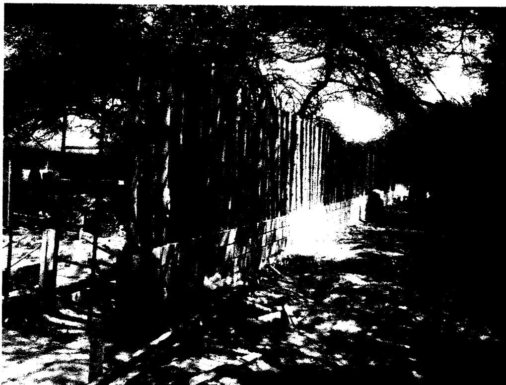
Foto 2.- Colocación de caña de bambú en tramo de cerco perimétrico.
