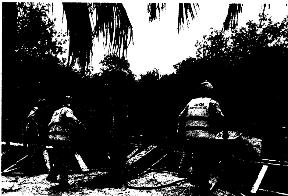
Foto 4.- Vaciado y vibrado de concreto f'c=315\text{kg}/\text{cm}^2 en muro de contención.
