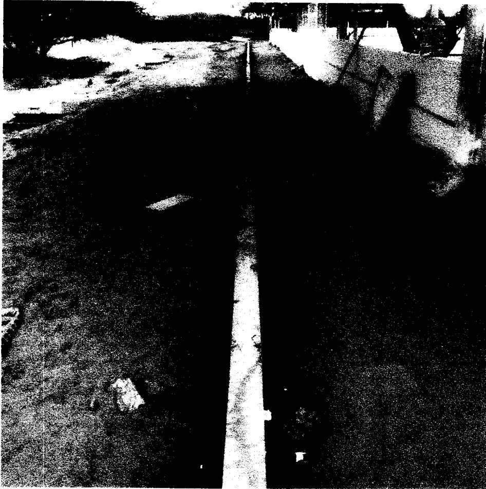
Foto 12.- Vista del sardinel de concreto en perímetro de los corrales.
