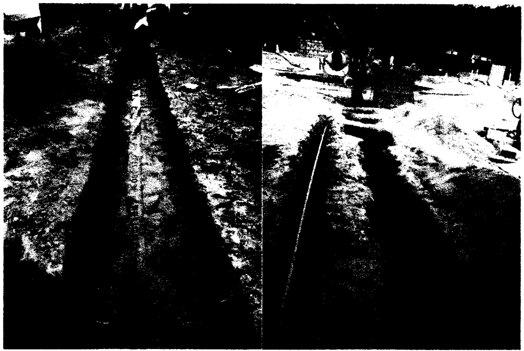
Foto 11.- Tendido de la red de alimentación eléctrica y la red de impulsión de agua potable.
